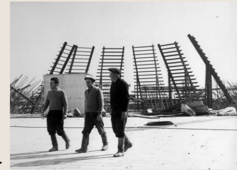
Tsitsernakaberd tijdens de bouw
